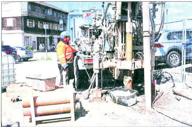
An 55 Stellen werden momentan Bodenproben für den Trassenbau der B33 entnommen. Foto: Stadt Haslach
